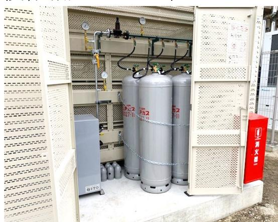
災害時でも起動できるよう、本市ではGHP（ガスヒートポンプ）方式を採用している。
