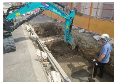
重機を使って表面の土を取り除き、遺構の痕跡を探します。
