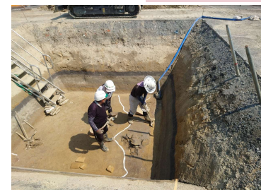
遺跡の有無や範囲、遺物の存在などを確認するため、機械を用いて幅1~2メートルの試掘坑を掘削します。
