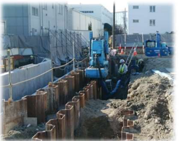
(鋼矢板設置工事イメージ)
