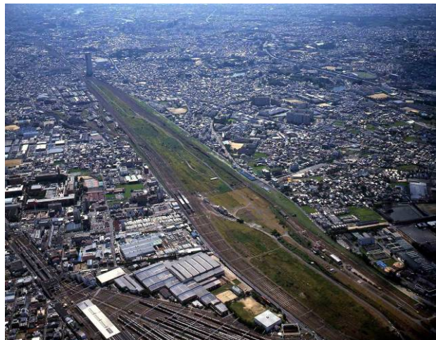
現在の吹田操車場跡地
