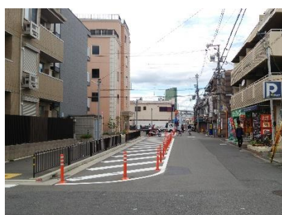
幅員 12.0mへ拡幅予定の道路 (一部暫定的に歩道整備)
