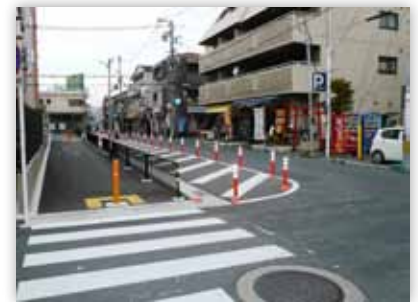
阪急正雀駅前の歩道整備
