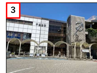
バス停上屋劣化 EV外壁劣化
