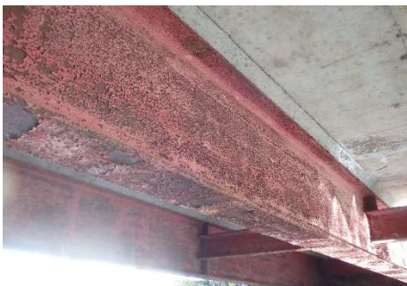
主桁の腐食 (判定Ⅲ)
