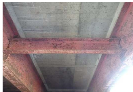
横桁の腐食 (判定Ⅲ)
