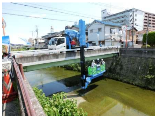
橋梁点検車による点検
