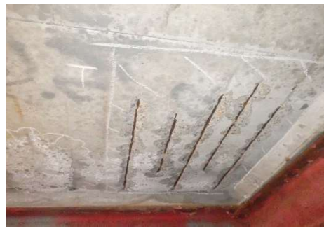
コンクリートの剥離・鉄筋露出 (判定Ⅲ)
