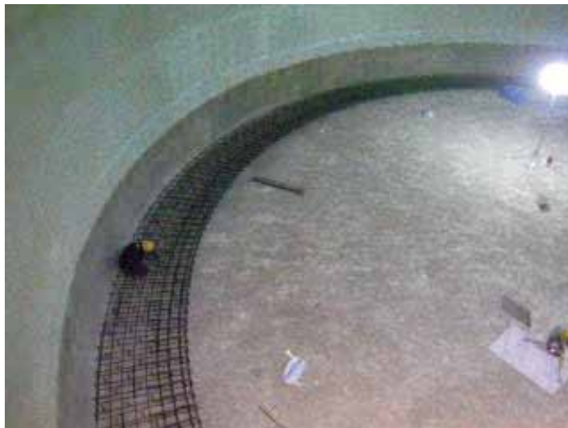
図 1-14 耐震化工事の様子 (鳥飼送水所 4号配水池)
