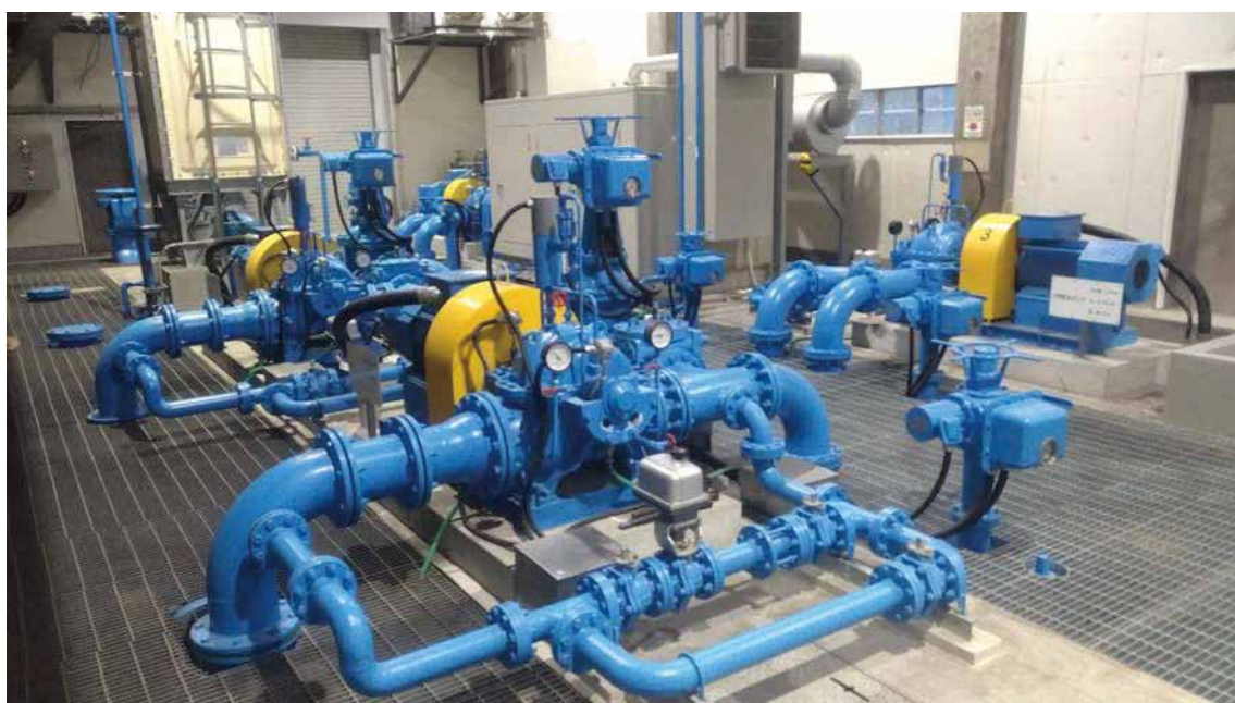
図 1-44 高効率ポンプ (中央送水所)
