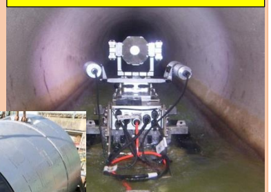
TVカメラ調査中の管渠内の様子
