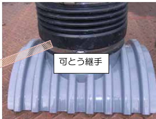
図 2-21 リブ管・可とう継手の施工時の様子
