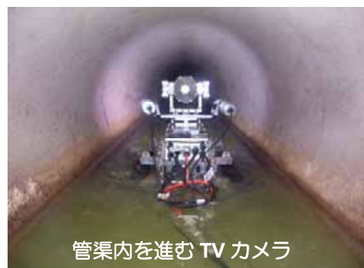
図 2-5 TVカメラ調査中の管渠内の様子
