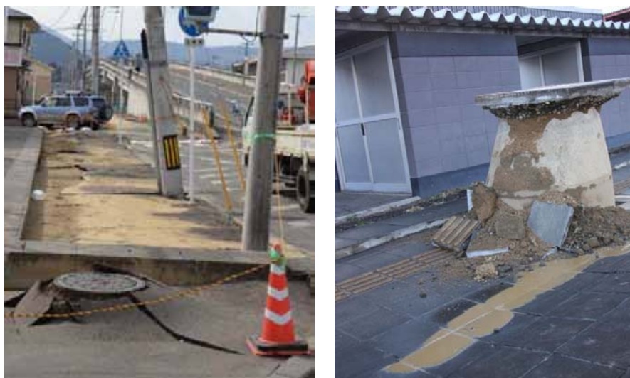
図 2-20 液状化被害の事例
