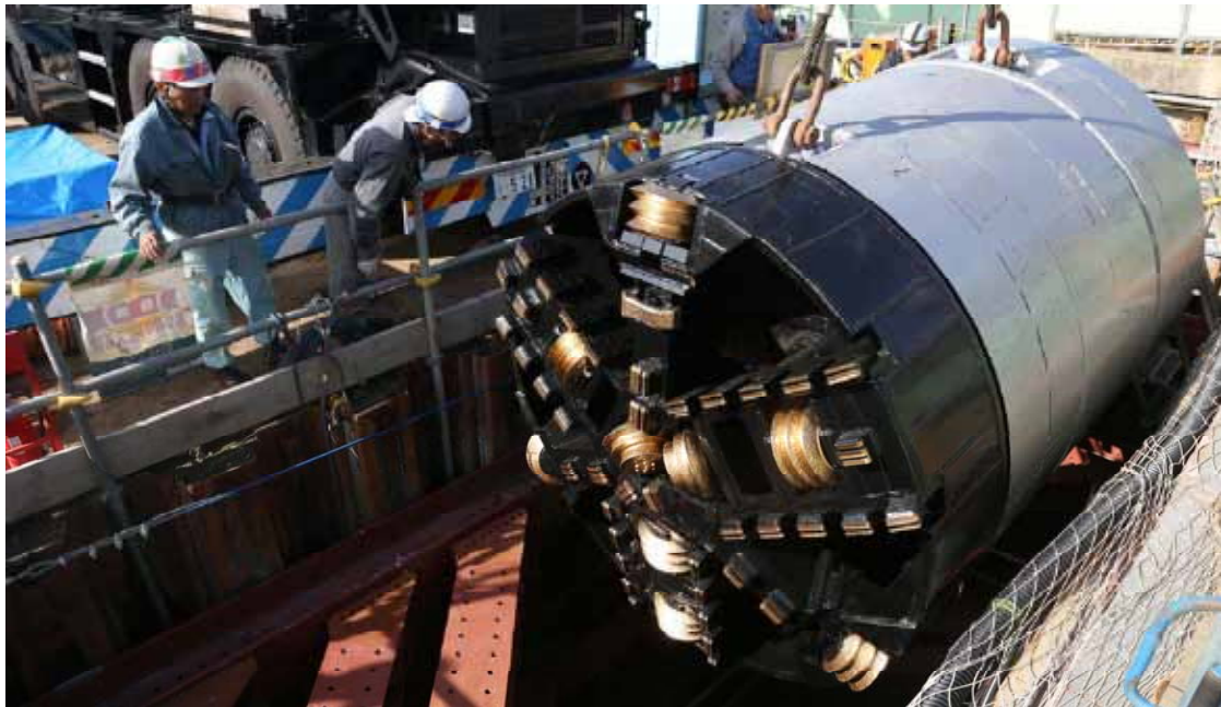
図 2-14 三箇牧鳥飼雨水幹線の建設工事に使用している推進マシン
