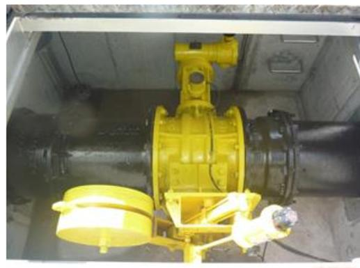
図 1-17 緊急遮断弁（千里丘送水所）
