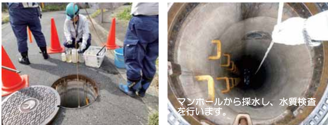
図 4-1 水質検査の状況
