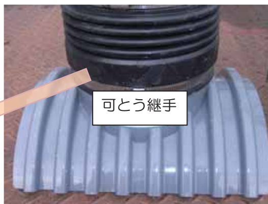
図 2-27 リブ管・可とう継手の施工時の様子
