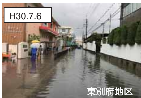
図 2-16 浸水被害状況
