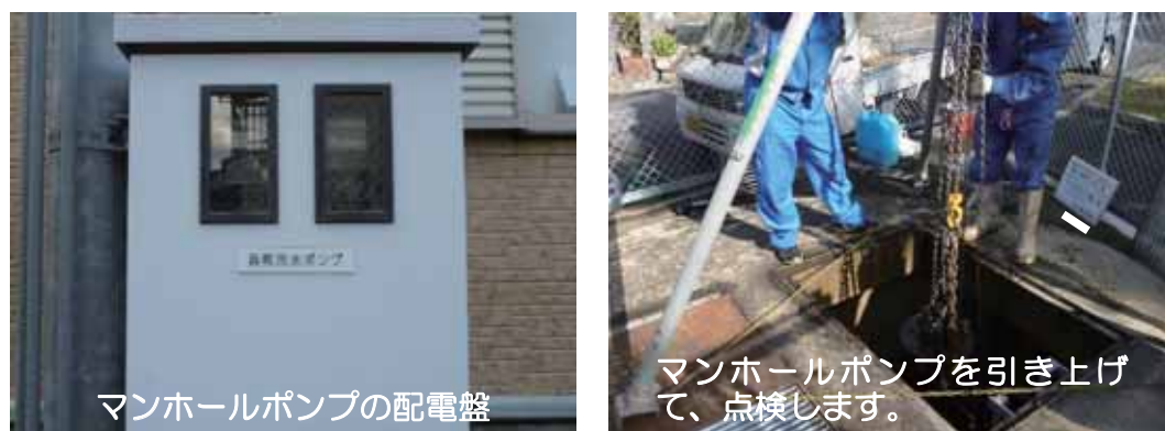
図 2-8 マンホールポンプの点検時の様子
