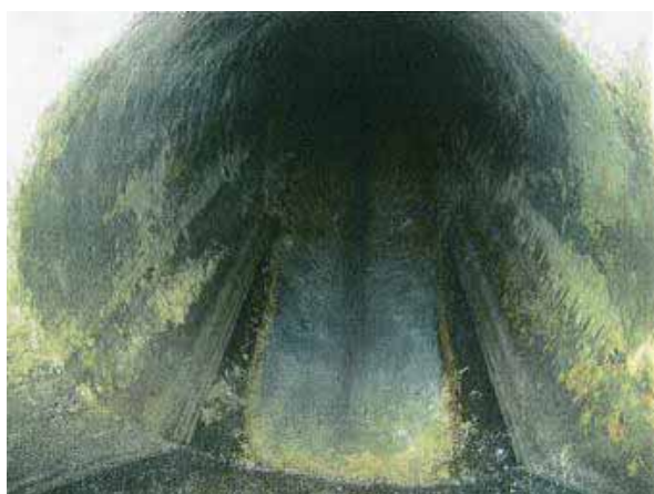
図 1-5 TV カメラ調査※中の管渠（鉄筋コンクリート管）内の様子
