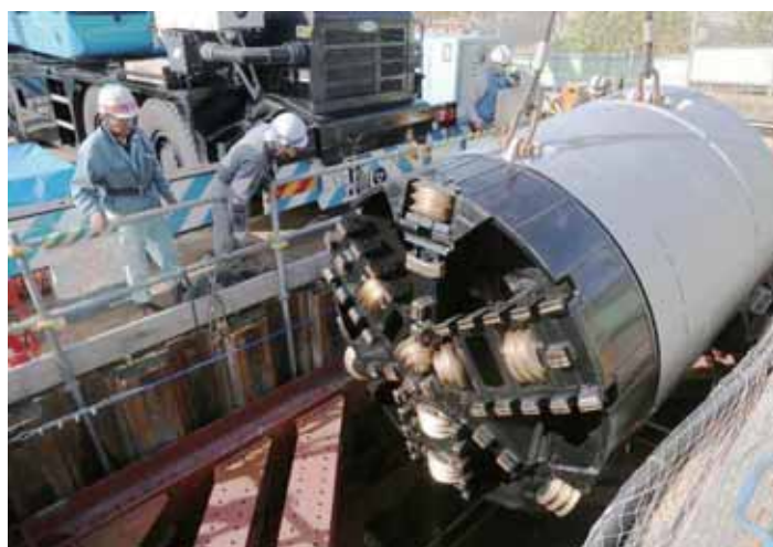
図 2-19 三箇牧鳥飼雨水幹線の建設工事に使用している推進マシン
