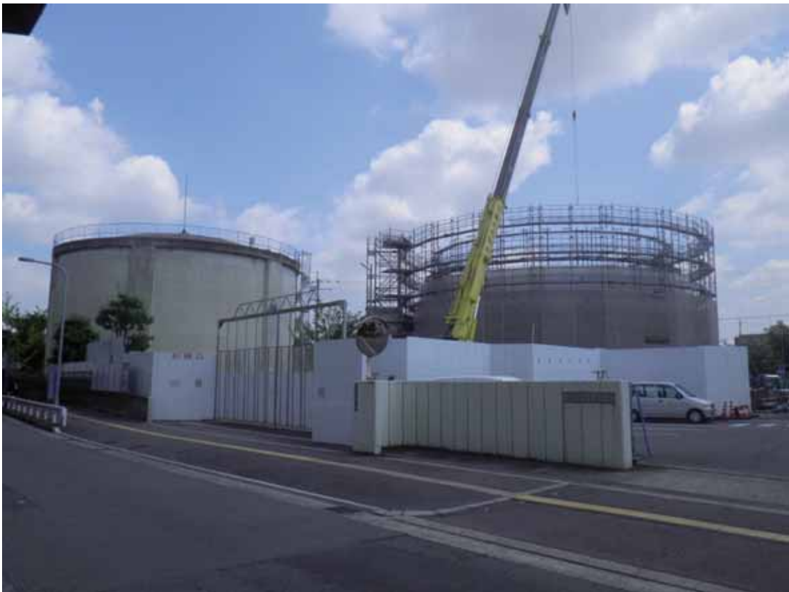
図 1-13 配水池更新工事の様子（中央送水所 1号配水池）
