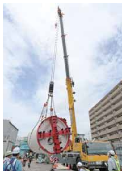
図 2-20 東別府雨水幹線の建設工事に使用しているシールドマシン
