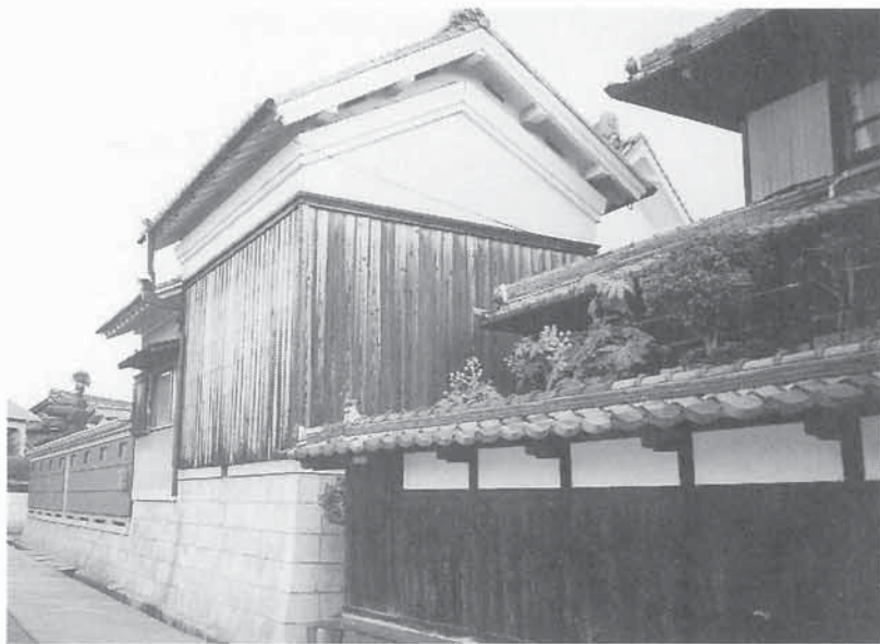
▼石積みの上に建つ段倉
