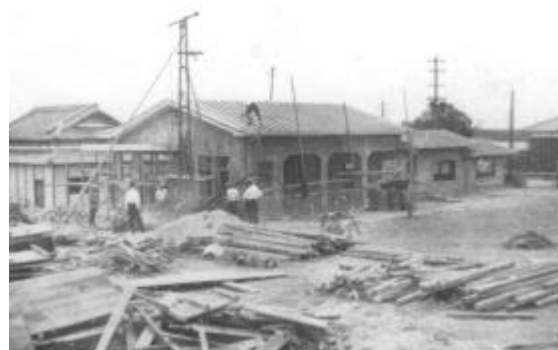
建設中の千里丘駅（昭和12年10月）
