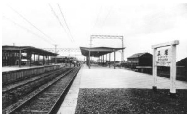
昭和3年開設当時の正雀駅ホーム
