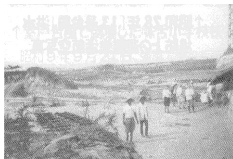
←大阪金属工業工事始まる
