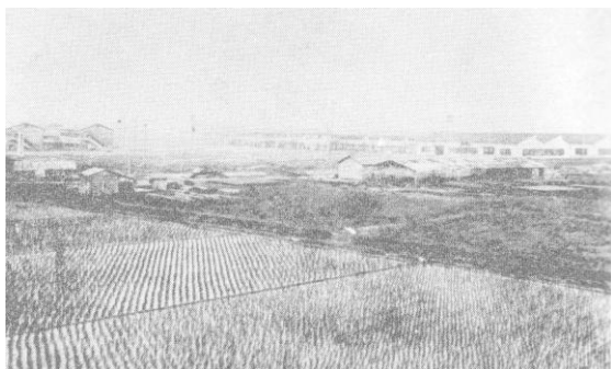
大阪金属工業淀川工場の建設風景
