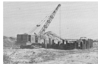
第1号地点遠景
