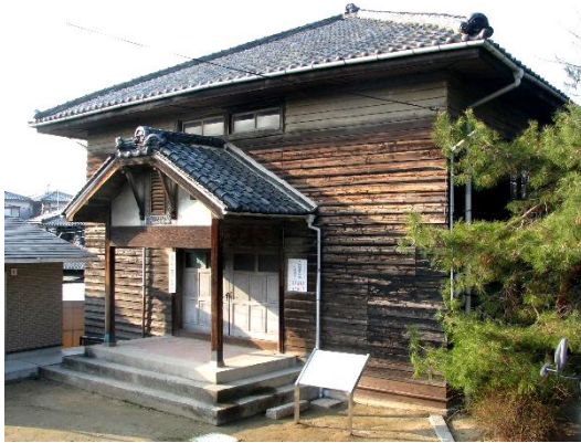
旧一津屋公会堂 外観
