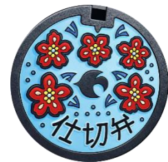
現況の仕切弁蓋
