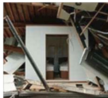
耐震シェルターの例
