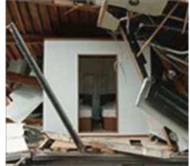
耐震シェルターの例
