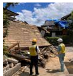
八代市で、被災家屋の被害状況を調査
