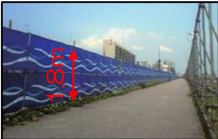
フェンスバリケード
