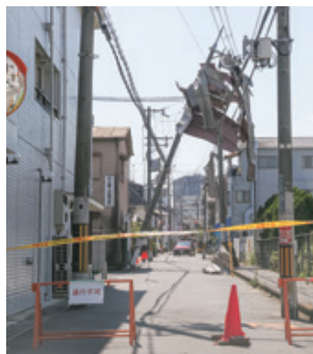
台風による被害（平成30年9月）
