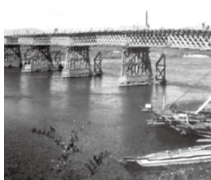
△ 鳥飼大橋(木造)着工
