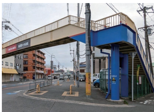
青色に塗られている部分が淀川氾濫時の最大浸水深（鳥飼野々歩道橋）
