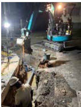
△水道管を更新する工事の様子
