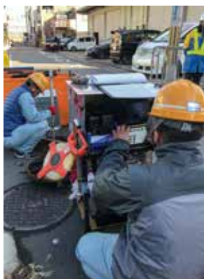
マンホールにTVカメラを入れる様子
