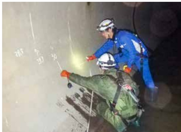
△委託業者による詳細調査
