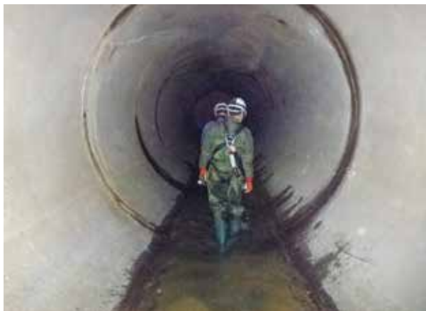
△委託業者による詳細調査
