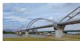
淀川にかかる水管橋
