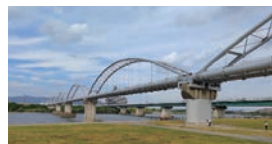
淀川にかかる水管橋
