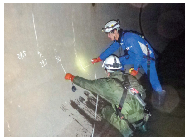
△委託業者による詳細調査
