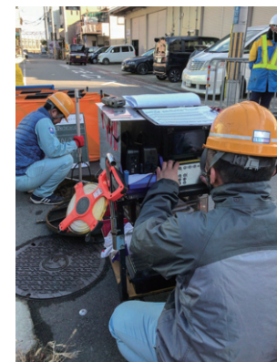
マンホールに TV カメラを入れる様子
