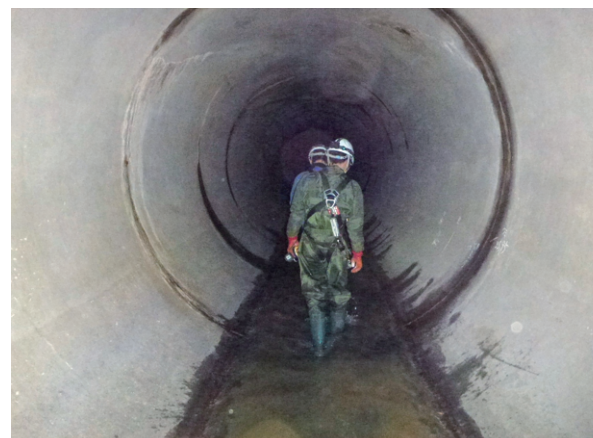
△委託業者による詳細調査
