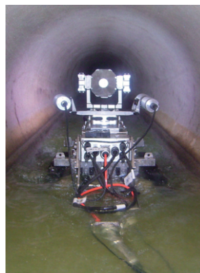
点検用の TV カメラが 下水道管内を調査する様子
