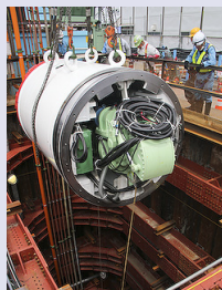
△雨水幹線工事
