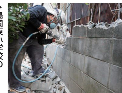
▶鳥飼東小学校のブロック塀撤去作業
