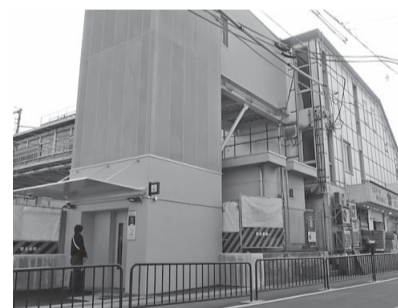
○JR千里丘駅西口エレベーター設置事業(4,243万円)
